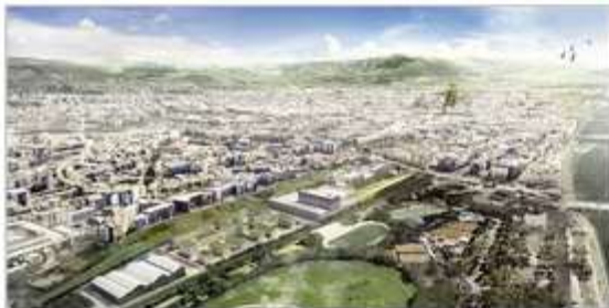
Das Gelände der Offici Grande Riparazioni in Florenz wartet auf einen neuen Entwicklungsplan.
